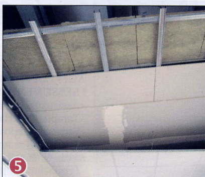
Nelle immagini: 1 e 2 - due momenti della realizzazione delle pareti divisorie aula - aula; 3 - isolante acustico applicato al solaio; 4 - striscia perimetrale di contenimento; 5 - isolamento acustico del corridoio; 6 - isolamento acustico delle aule.
