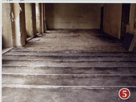
In alto: fig. 2, fig. 3, qui sopra fig. 4 intradosso solai lignei e fig. 5 estradosso solai misti (legno – metallo).
