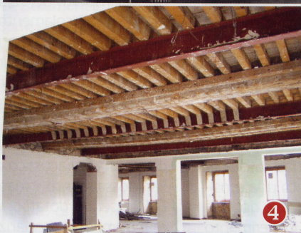
In alto: fig. 2, fig. 3, qui sopra fig. 4 intradosso solai lignei e fig. 5 estradosso solai misti (legno – metallo).
