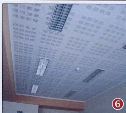
Nelle immagini: 1 e 2 - due momenti della realizzazione delle pareti divisorie aula - aula; 3 - isolante acustico applicato al solaio; 4 - striscia perimetrale di contenimento; 5 - isolamento acustico del corridoio; 6 - isolamento acustico delle aule.
